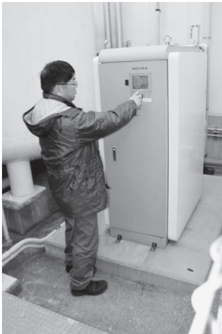
ボイラ給水加温ユニット「VH」はヒートポンプと熱交換器を組み合わせた熱回収システム
